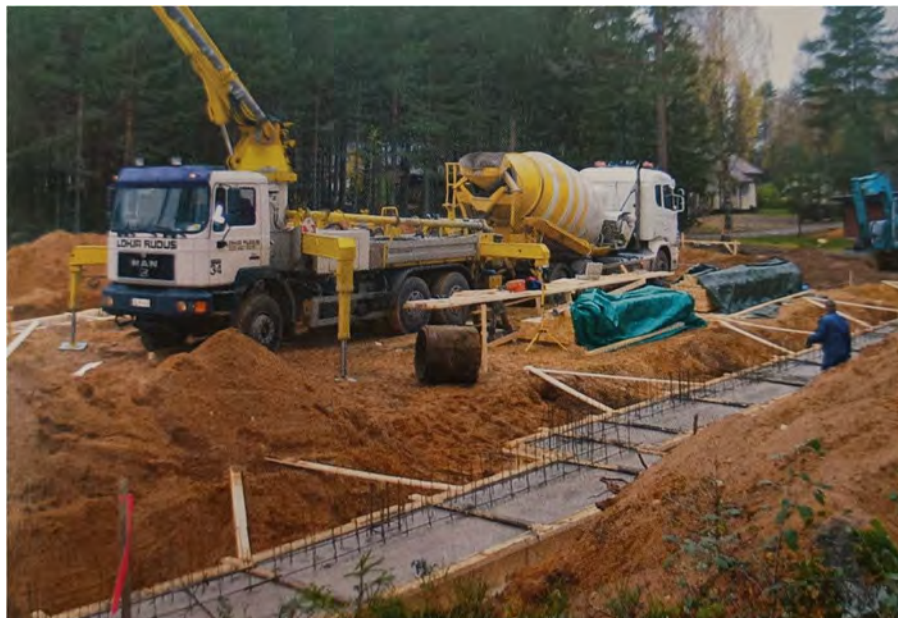
Kuva 63. Uuden venehallin anturoiden valua.
