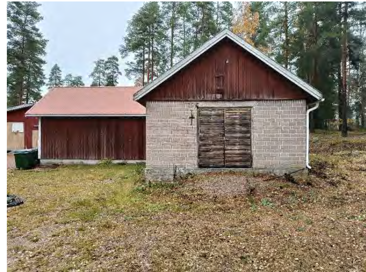
Kuva 36. Tinaverstaan eteläpääty. Vasemmalla puurakenteinen puuvarasto.
