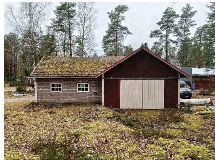
Kuva 37. Tinaverstaan itäjulkisivu, oikealla puuvaraston pääty.
