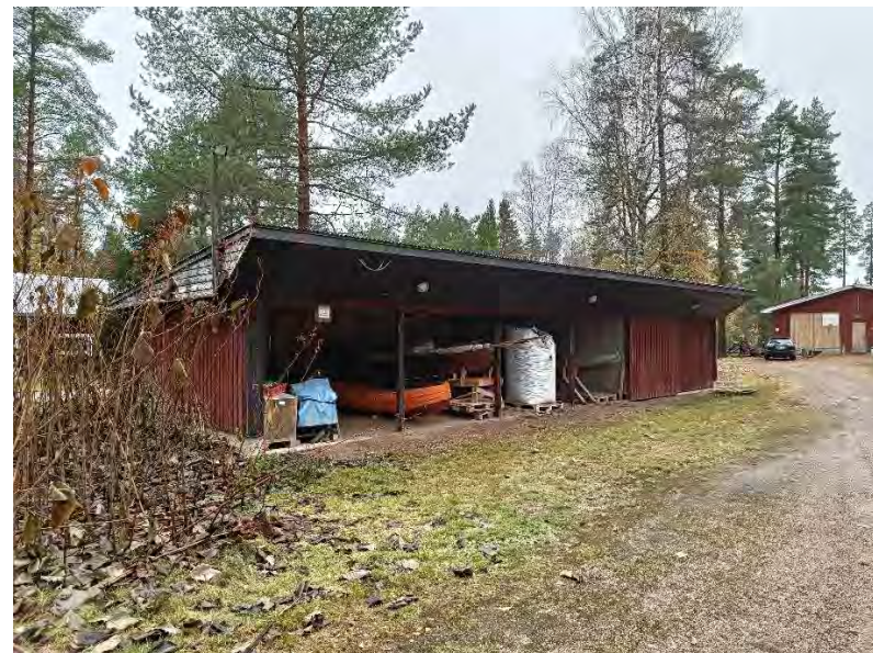
Kuva 74. Autokatos kuvattuna kaakosta.
