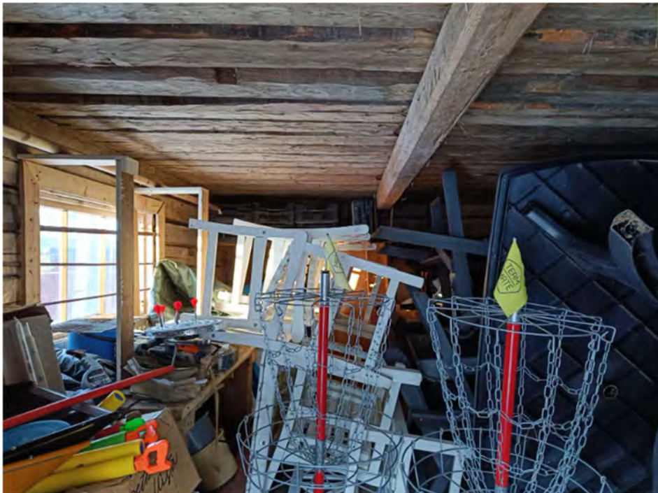
Kuva 25. Sisäkuva aitan ensimmäisestä kerroksesta.
