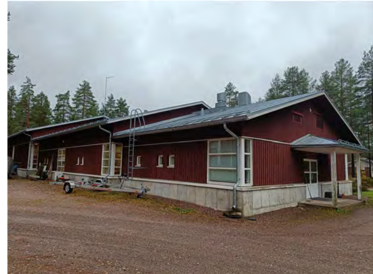
Kuva 66. Uuden venehallin julkisivuja.
