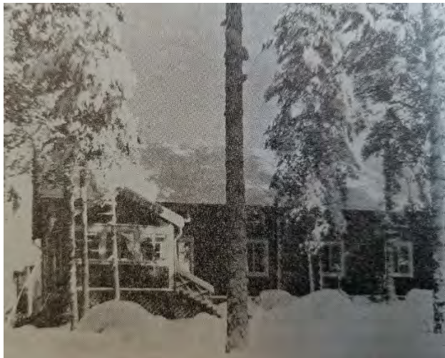
Kuva 4. Rehtorintalo eteläpuolelta kuvattuna.
