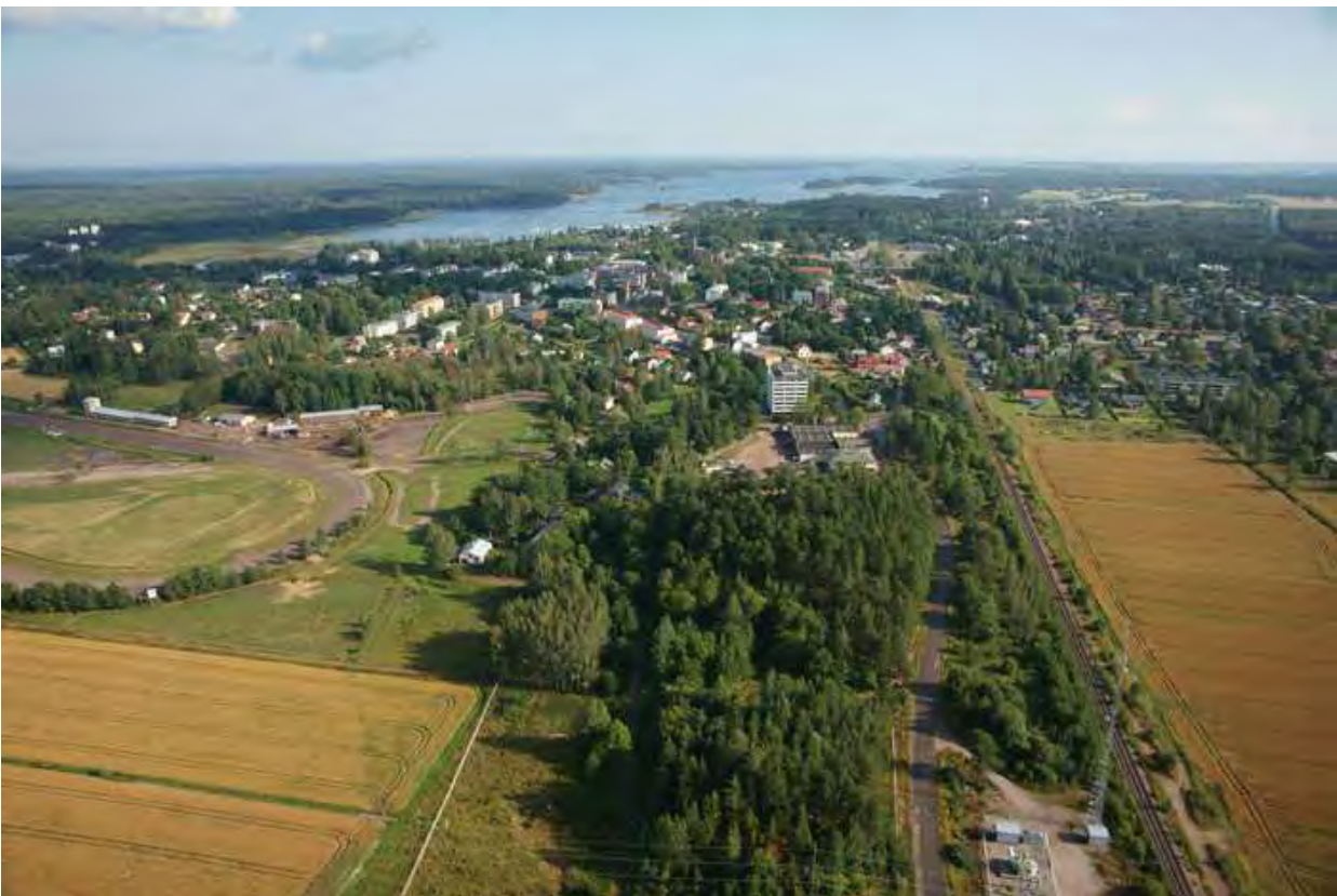
Bild 17. Flygbild från motorvägen mot åsen i söder. Kullen i mitten av bilden är naturskyddsområdet Bryggeribackens skog. Till höger i förgrunden finns en högspänningstransformatorstation för kraftledningen. Bredvid den finns en basstation för mobiltelefoner med tillhörande konstruktioner.
