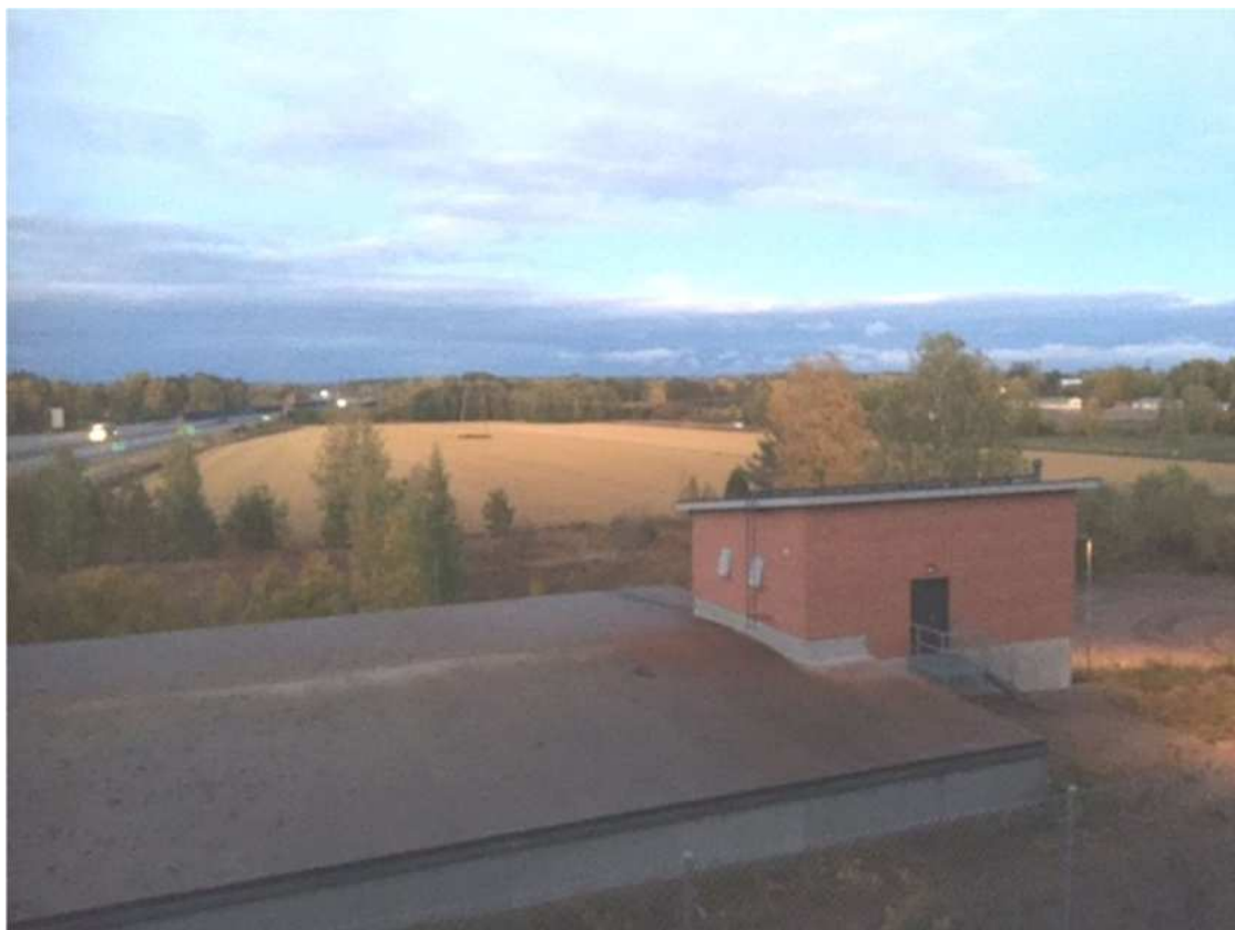
Bild 12. Vy från åsen mot sydost och ån över den 2015 byggda pumpstationen och vattenbehållaren.
