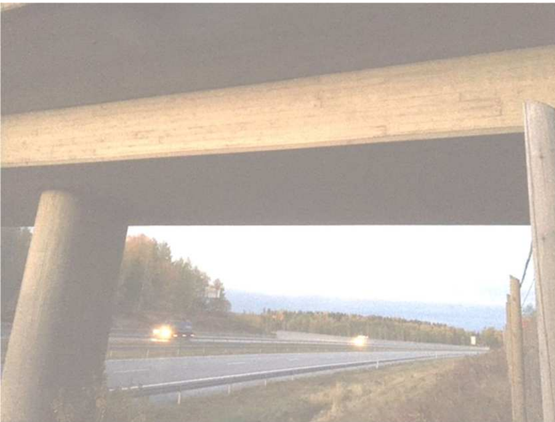
Bild 11. Södra sidan av bron för fordonstrafik sett mot öster.
