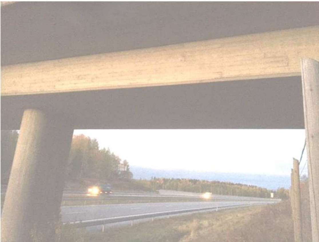
Kuva 11. Ajoneuvoliikenteen silta eteläpuolelta itään päin nähtynä.
