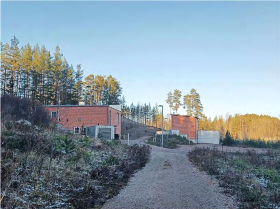
Vedenottamon kaksi rakennusta etelästä päin kuvattuna. Taaempi on vuonna 2015 rakennettu pumppaamo ja vesisäiliö.
