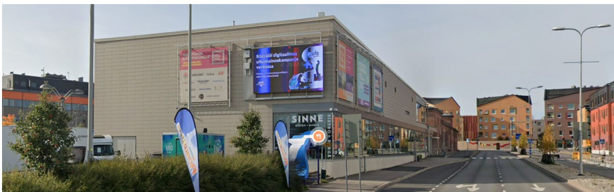
Esimerkki tyyppin 2 digitaalisesta mainostaulusta. Mainoksen vaikutusta julkisivulle pitää tarkastella kokonaisuutena. Digitaalisen mainostaulun sijainti julkisivussa ei ole huono, mutta tekee yhdessä isojen mainosjulisteiden kanssa kokonaisuudesta levottoman. Kuva: Porvoon taidetehdas. Google maps. 13.3.2024
