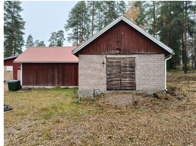
Kuva 36. Tinaverstaan eteläpääty. Vasemmalla puurakenteinen puuvararasto.
