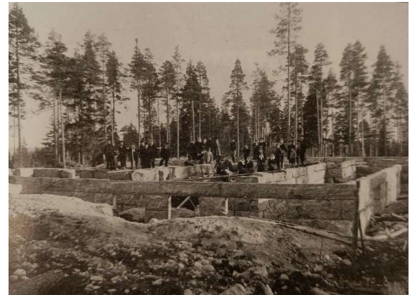
Kuva 6. Kuggomin päärakennuksen perustusten rakentamista. Perustukset on tehty kookkaista graniittikivistä.
