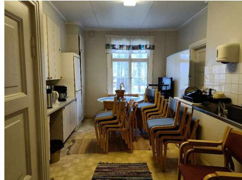
Kuva 33. Näkymä eteisestä keittiöön.
