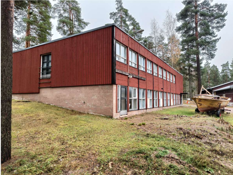
Kuva 52. Poikien asuntola pohjoisesta kuvattuna.
