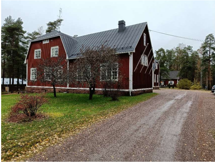
Kuva 9. Päärakennus etelästä saavuttaessa.
