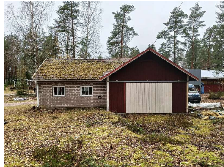
Kuva 37. Tinaverstaan itäjulkisivu, oikealla puuvaraston pääty.
