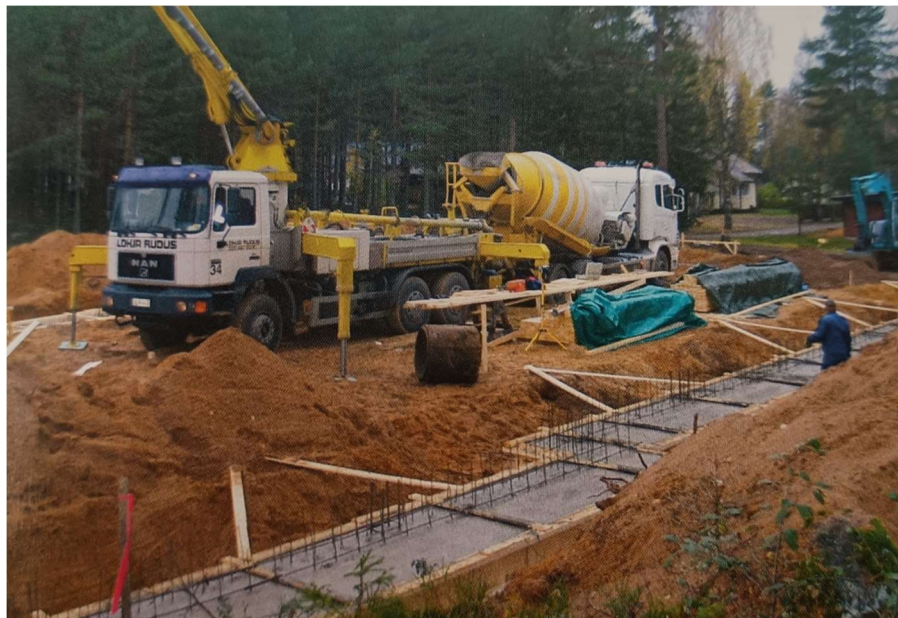
Kuva 63. Uuden venehallin anturoiden valua.
