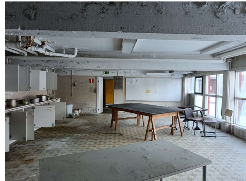
Kuva 55. Kellarikerroksen verstaas. Tilassa rakennettiin laskituveneitä 1970-luvulla, tällöin tilasta oli suuri oviaukko ulos veneiden haalausta varten.
