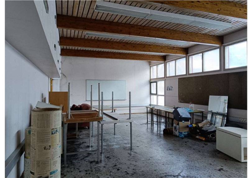
Kuva 54. Ensimmäisen kerroksen opetussali.
