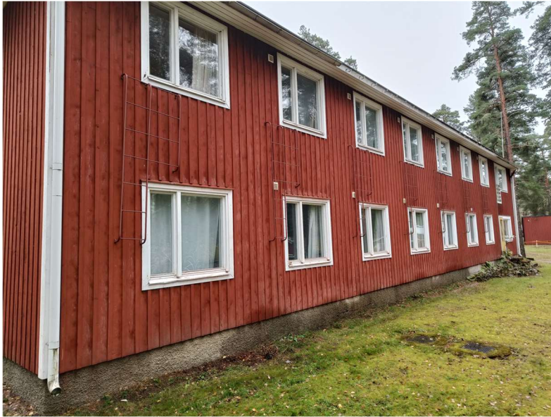
Kuva 46. Tyttöjen majoitustalon länsijulkisivu
