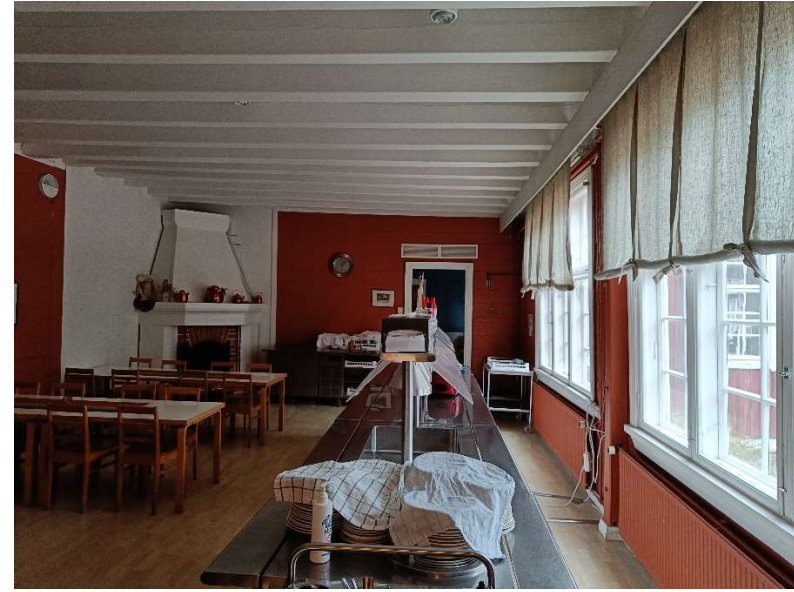
Kuva 15. Päärakennuksen ruokasali aulasta pohjoiseen kuvattuna.
