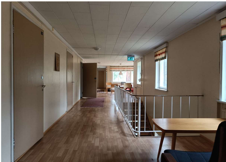
Kuva 47. Toisen kerroksen aula. Poistumiskyttin kohdalla oleva ulkoseinä on kertaalleen avattu kosteusongelmien takia.
