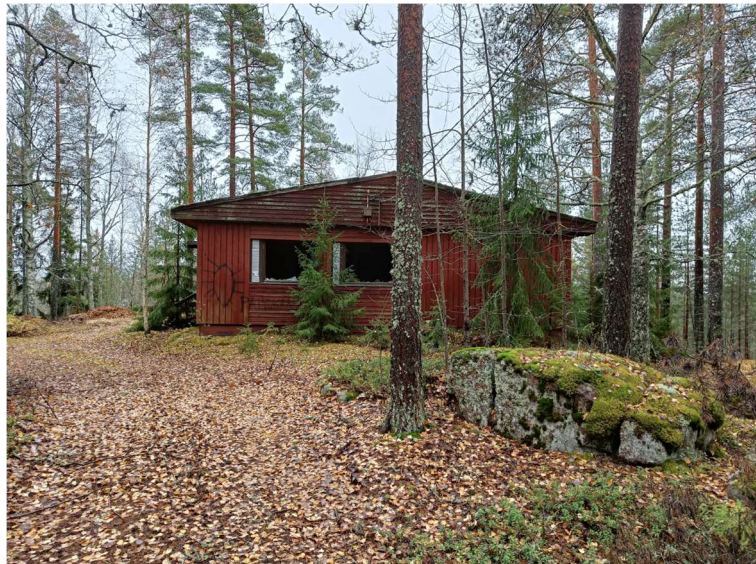
Kuva 50. Opettajien asuntolan pohjoisjulkisivua.
