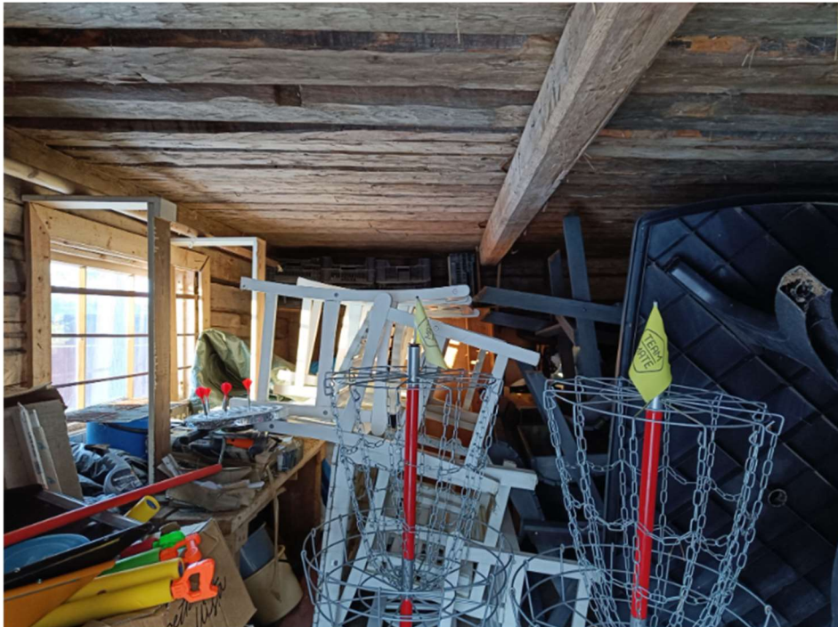
Kuva 25. Sisäkuva aitan ensimmäisestä kerroksesta.
