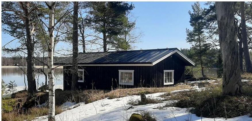
Bild 13. Båthuset på den nordöstra udden på byggplats 2.
