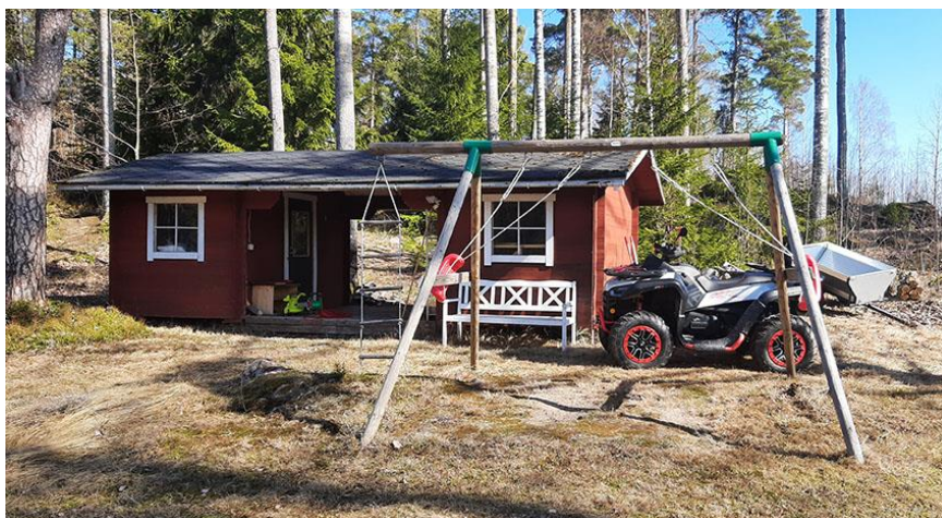
Bild 2. Lidret på byggplats 1.
