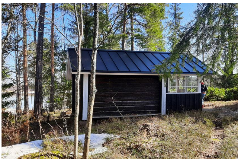
Kuva 12. Rakennuspaikan 2 mökin itäpuolella oleva liiteri.
