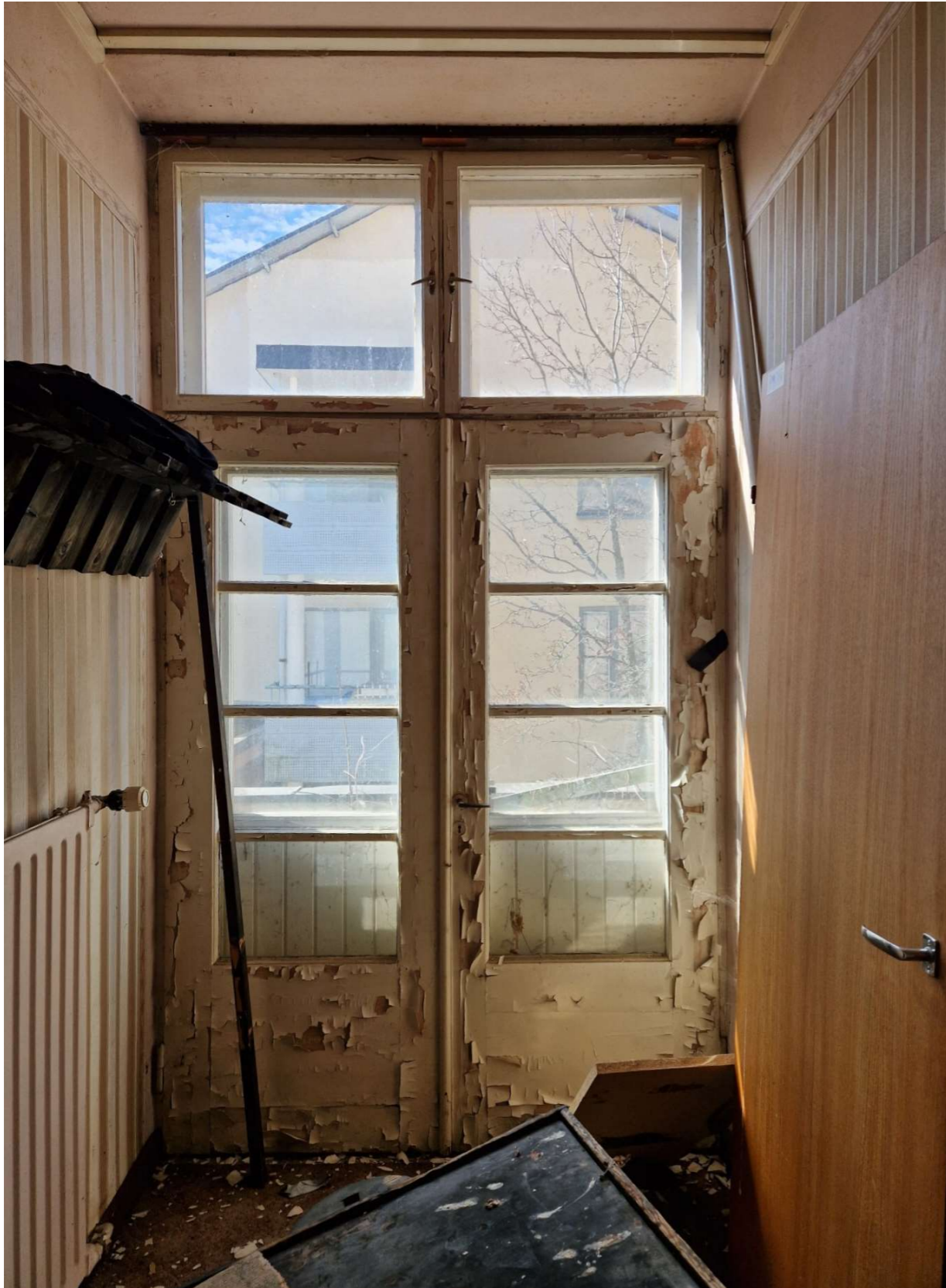
Kuva 49. Hotellikäytävän länsipäädyn ovi.
