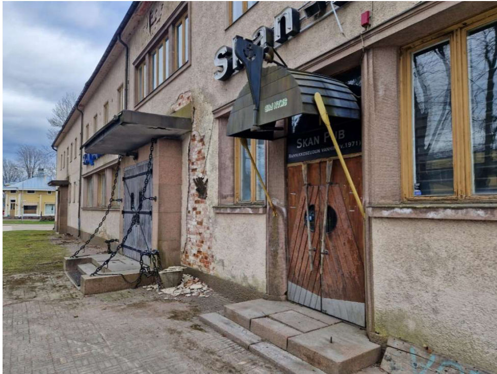
Kuva 25. Pohjoisjulkisivua. Etualalla Skan-Pubin ovi, joka on ilmeisesti alkuperäinen, mutta verhoiltu uudestaan vanerilla ja laudoilla. Se vasemmalla puolella on hotelli-ravintolan ovi, joka on uusittu. Sitä ja taampaa ovea kiertää graniittiharkot. Ikkunat ovat ravintolan ikkunoissa muita suuremman ja niiden ympärillä on terastirappaus samoin kuin etualan ovenpielissä.
