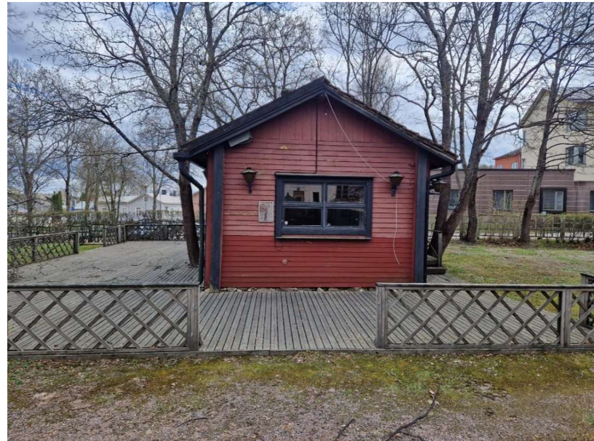
Kuva 53. Piharakennuksen julkisivu pohjoiseen.
