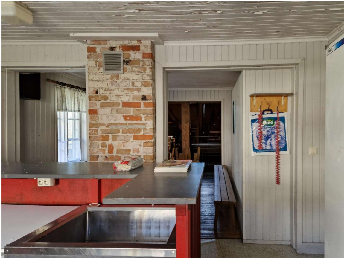
Kuva 55. Sisäkuva piharakennuksen hirsirakenteisesta pohjoispäädystä etelään päin. Ikkunan sisäpuiteessa on ruutujako.
