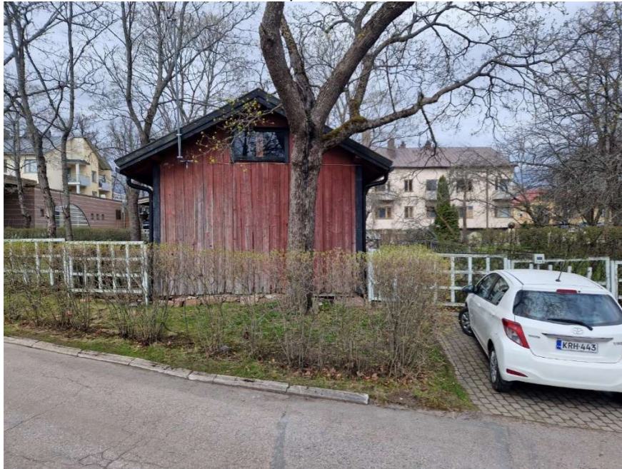
Kuva 51. Piharakennuksen julkisivu etelään.
