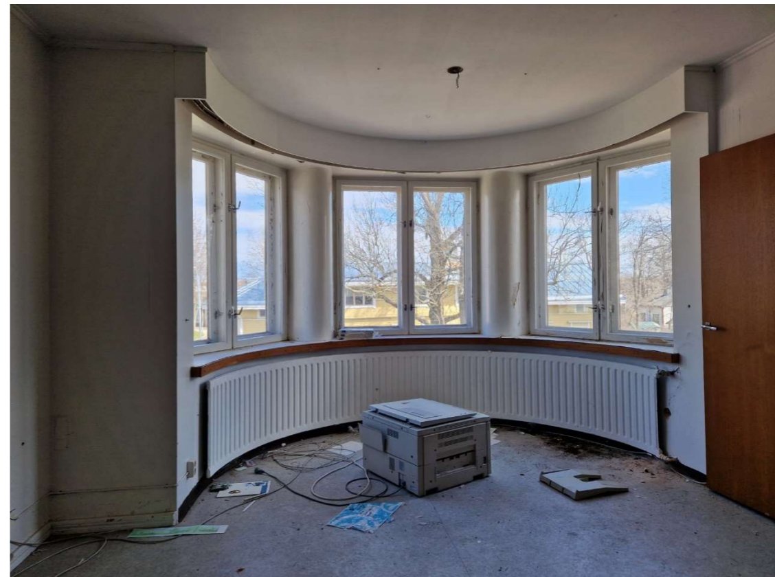
Kuva 44. Toisen kerroksen itäpäädyn erkkerihuone.
