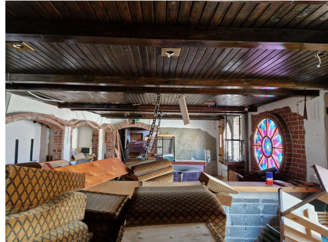
Kuva 39. Näkymä ravintolasalista eteiseen päin. Katto on 60-70-luvun remontista, muut pinnat on uusittu 90-luvulla tai sen jälkeen.
