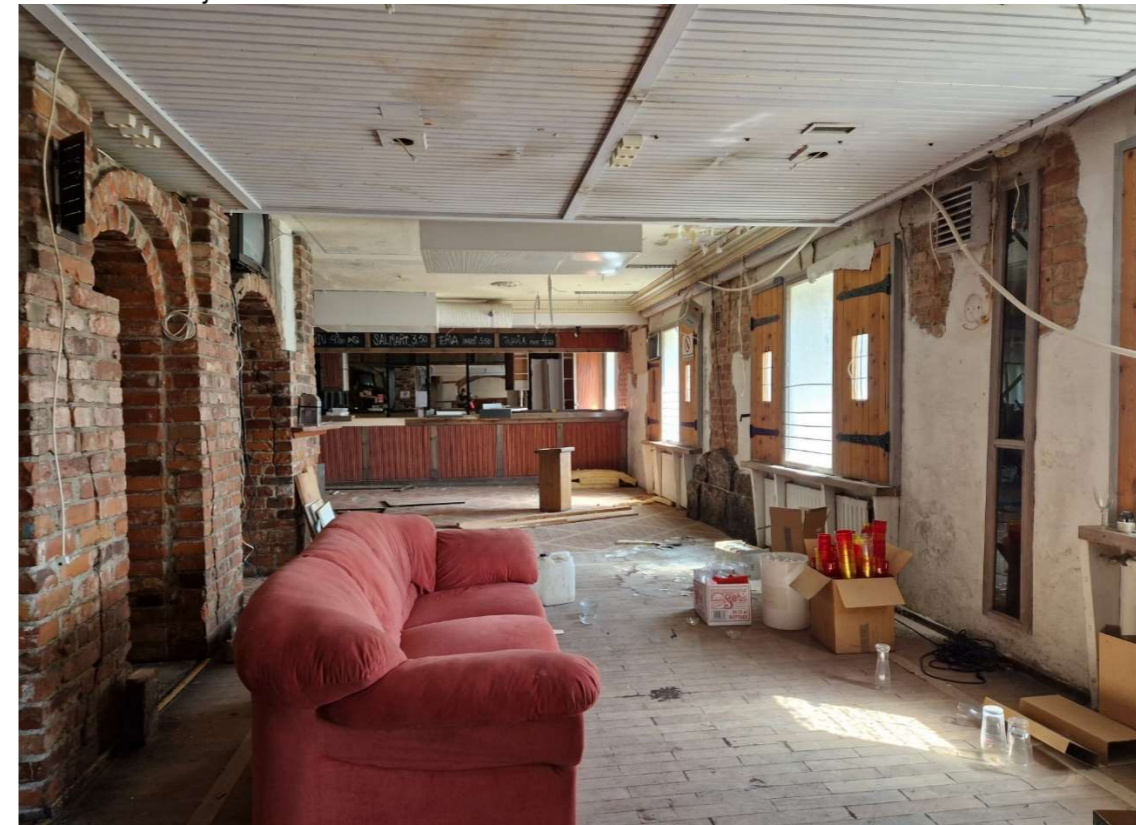
Kuva 40. Edellisen kuvan vasemmalla puolella olevaa ravintolatilaa. Päädyssä olevan tiskin paikalla on ollut kapea American bar -tila 1960-luvulla.
