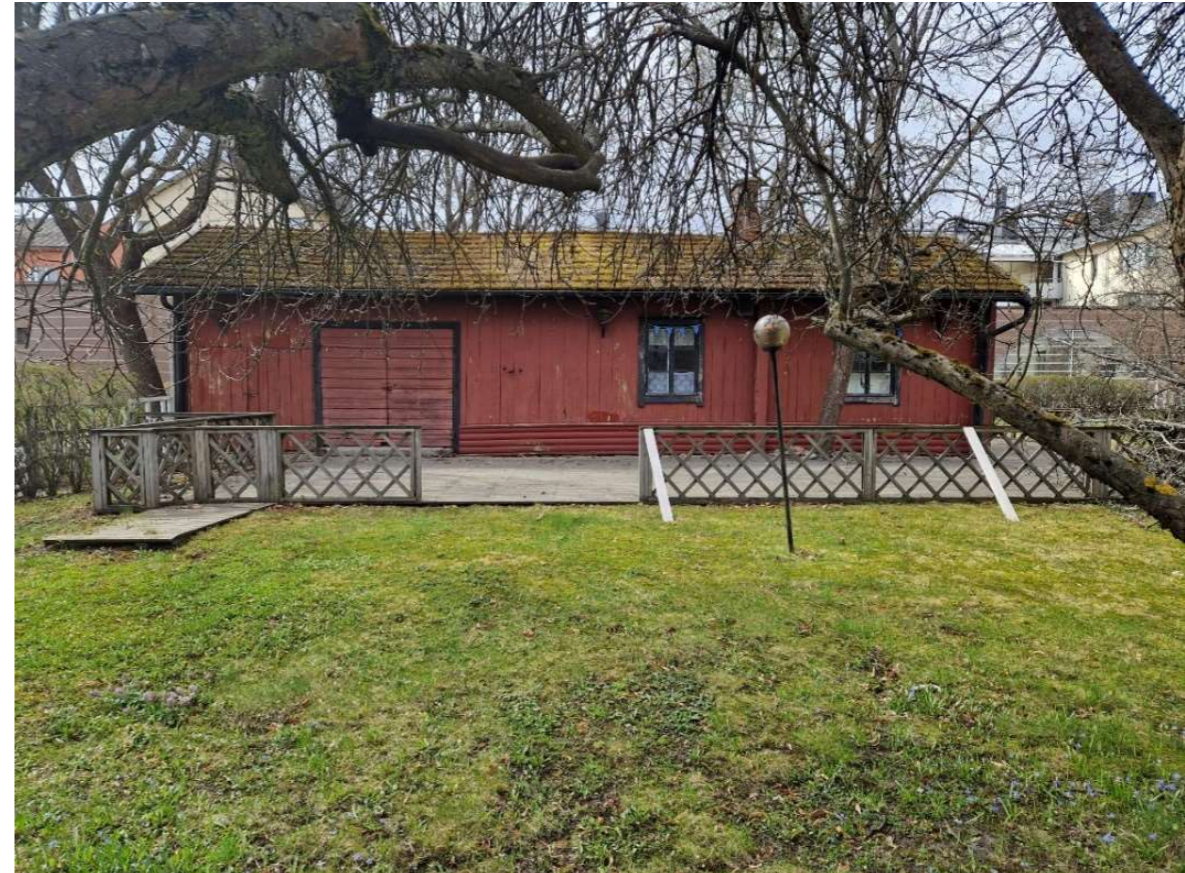
Kuva 54. Piharakennuksen julkisivu itään.
