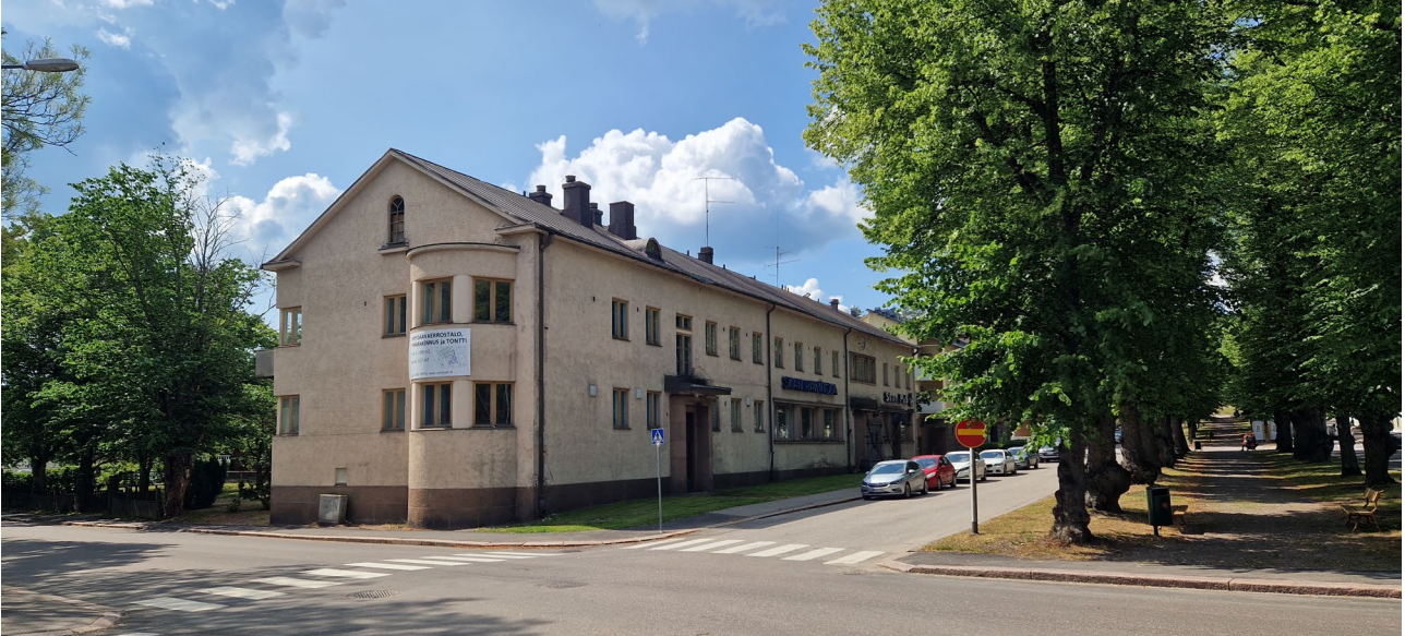
Tiilirakennus suunnittelualueella. 1940-luvulta. Rajautuu Karlskronabulevardiin ja Mariankatuun.
