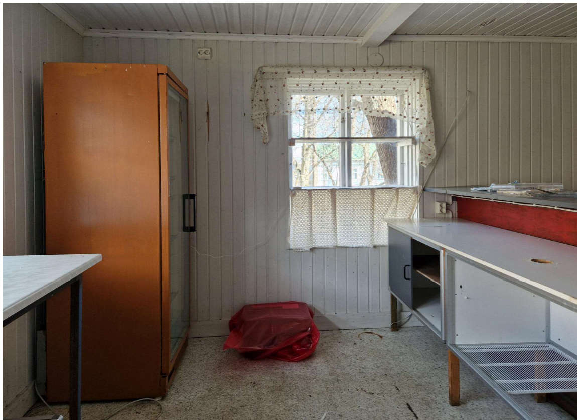
Kuva 56. Sisäkuva piharakennuksesta itään päin.
