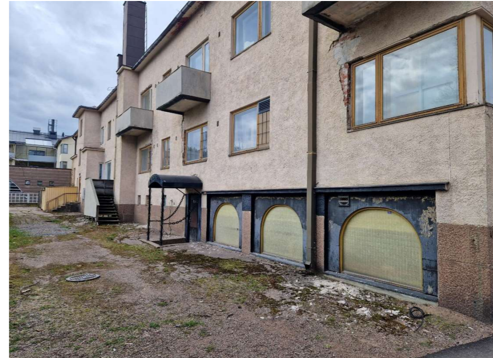
Kuva 27. Eteläjulkisivua. Toisen kerroksen parvekkeet ovat teräsbetonirakenteisia. Etualalla on kellarin uima-allasastomuutoksen yhteydessä tehdyt kaari-ikkunat. Taaempana on uusi ulko-ovi portaitteen vuodelta 1991.
