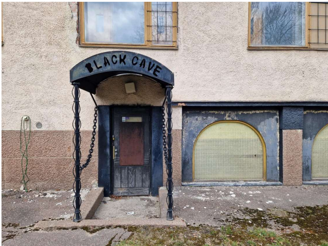
Kuva 30. Sisäänkäynti kellarin. Paikalla on ollut alun alkaen pihassa syvennys ja ovi. Kaari-ikkunat on tehty ilmeisesti uima-allasosastomuutoksen myötä vuonna 1975.
