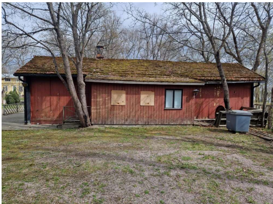
Kuva 52. Piharakennuksen julkisivu länteen.
