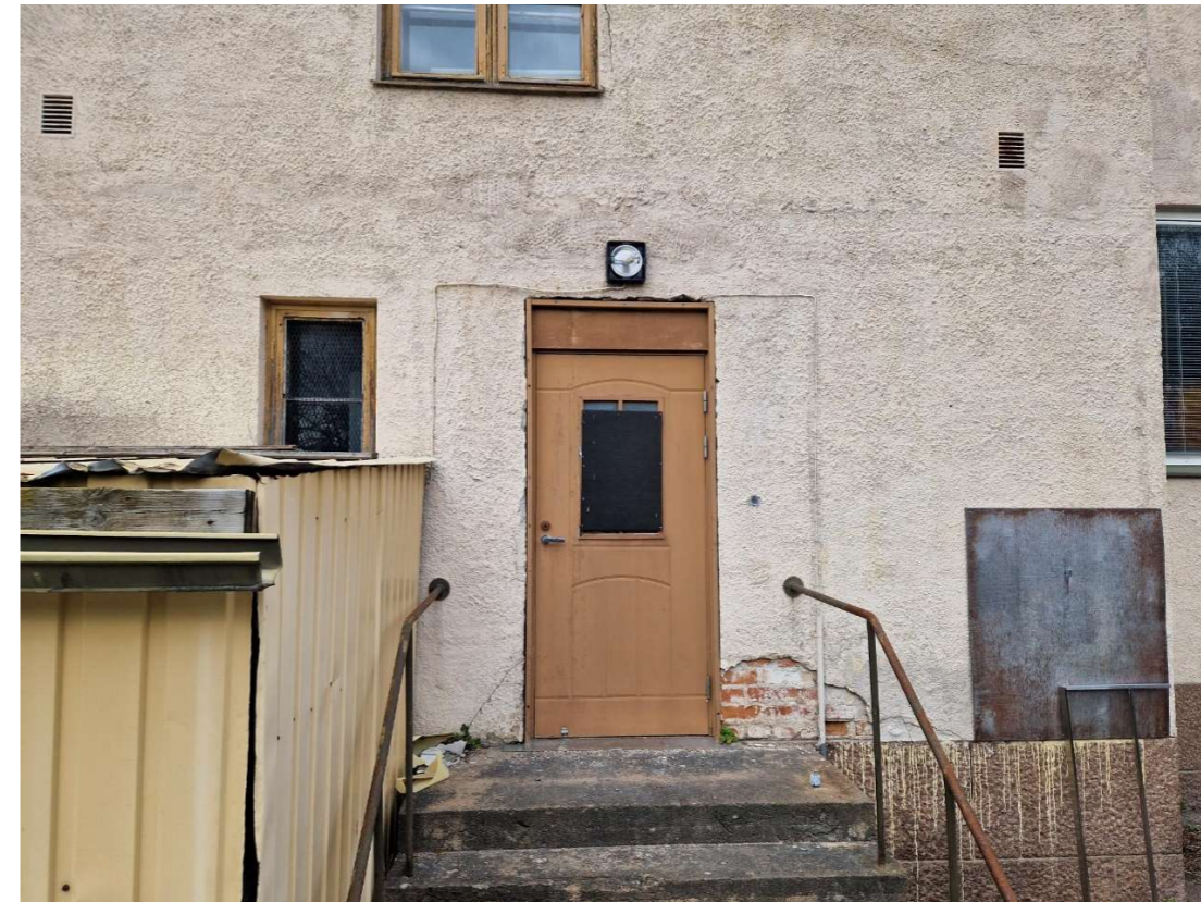
Kuva 32. Porrashuoneesta pihalle johtavan oven paikka on alkuperäinen, ovi on uusittu.
