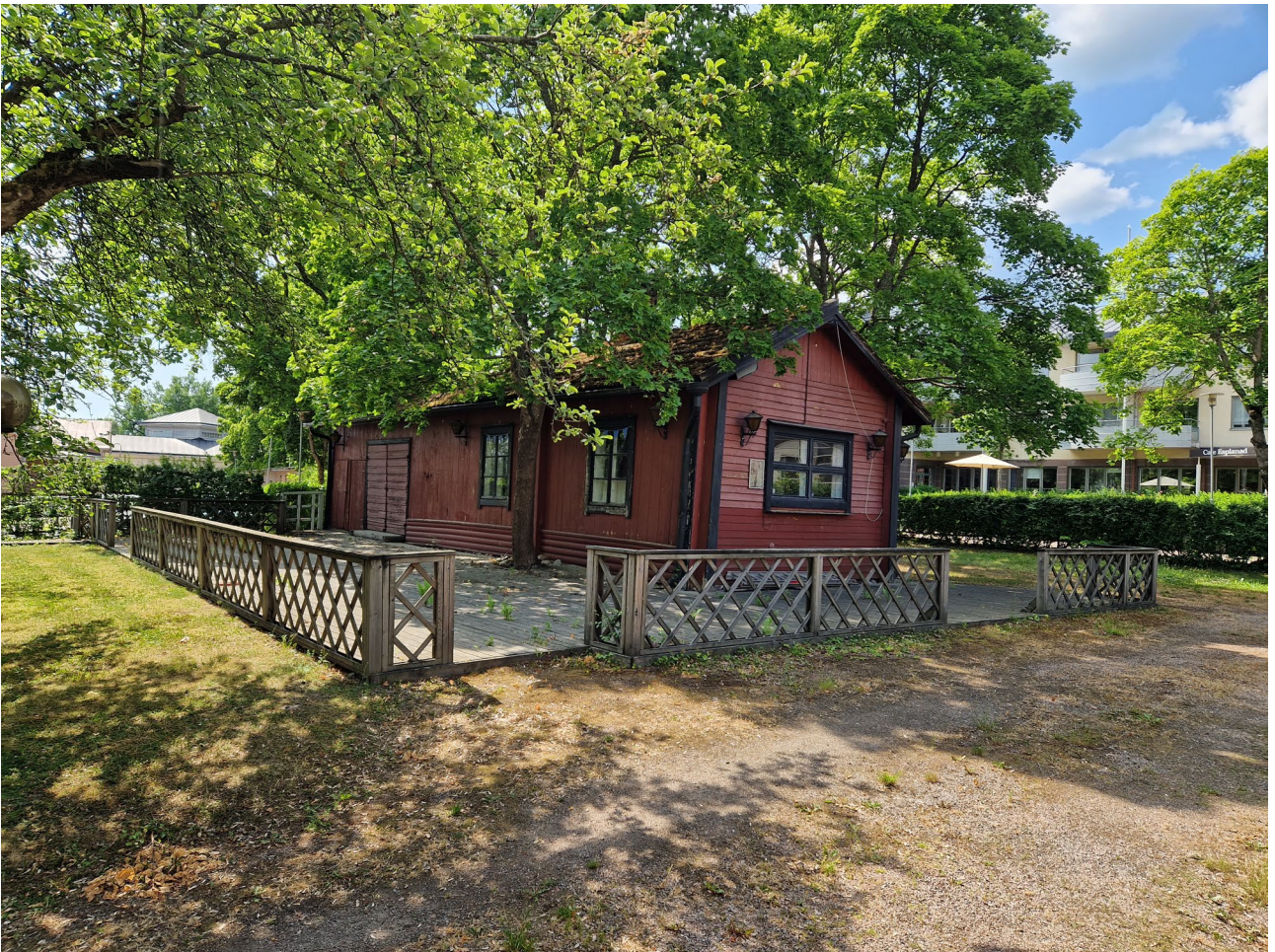
Suunnittelualueen toinen rakennus on vanhahko puurakennus, jota on ensisijaisesti käytetty kahvilana ja ravintolana kesäaikaan...
