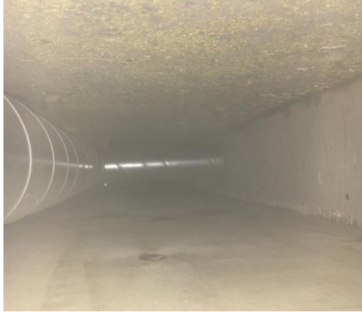
Kuva 3. Liikuntahallin lattian alle menevät poistoilmaputket lyhyemmän ulkoseinän kohdalla
