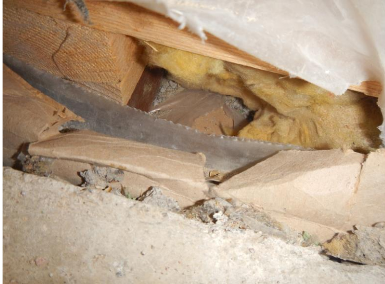
Kuva 1. Liikuntasalin lattian rakenneavaus. Aistinvaraisesti arvioiden rakennusmateriaalit ovat kunnossa eikä avauskohdassa havaittu poikkeavia hajuja.
